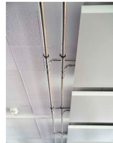
Raccordement de plafonds rafraîchissants avec Geberit Mapress Therm.
