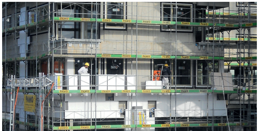
Die Wärmedämmung stellt einen festen Bestandteil der Gebäudehülle dar. Die eingesetzten Materialien ergeben neue Herausforderungen für die langfristige Verwertung.
